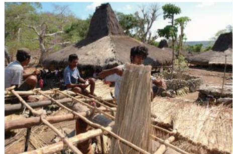
d.チガヤ葺き作業(インドネシア/スンバ島)
