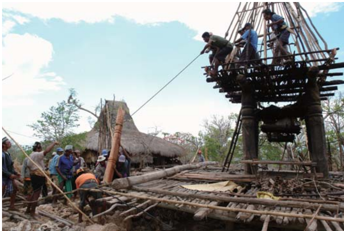
b.住居工事風景(インドネシア/スンバ島)
