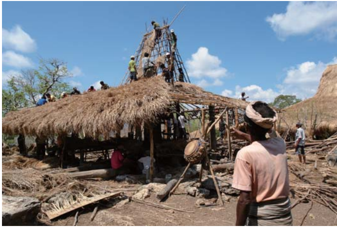
a.住居工事風景(インドネシア/スンバ島)
