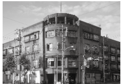
清砂通りアパートメント (撮影: 兼平雄樹)
