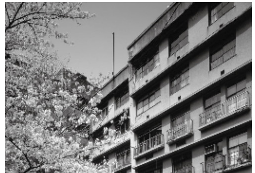
江戸川アパートメント (撮影: 兼平雄樹)
