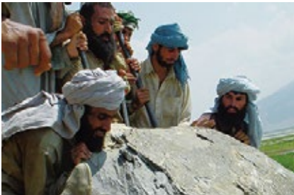
手作業で工事を進めていく
