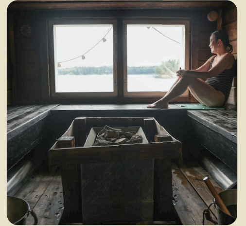
立ち昇るロウリュを全身で浴びることができるように、ベンチはストーブの石より高い位置にある（17頁参照）。
